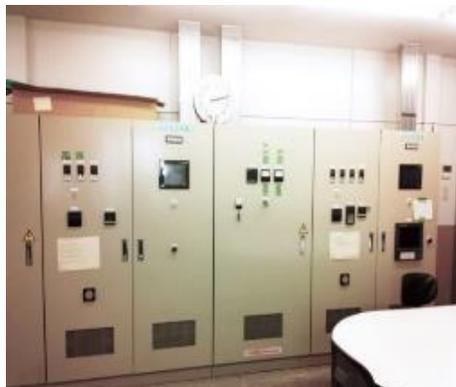
反応炉制御盤
